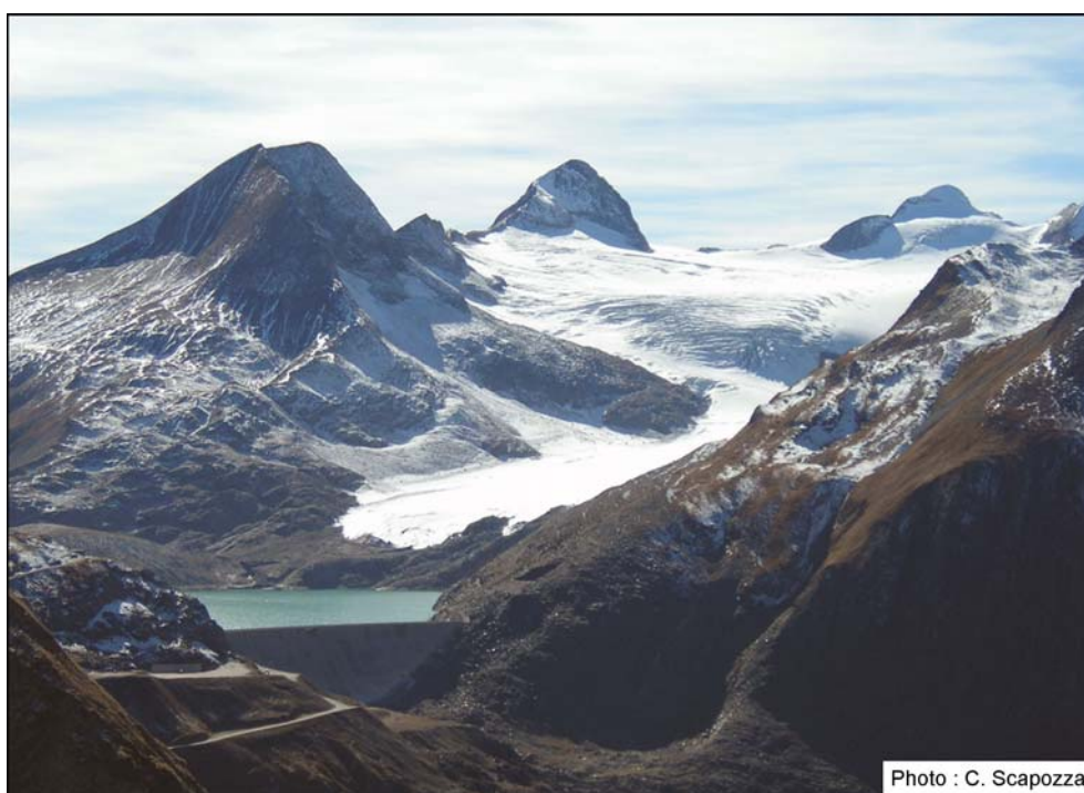
Fig. 1 – Le barrage de Gries avec, à l'arrière plan, le glacier homonyme (Col du Nufenen, VS). Ce barrage, bien que situé en territoire valaisan, alimente les usines de l'Ofima (Officine Idroelettriche della Maggia) au Tessin.
